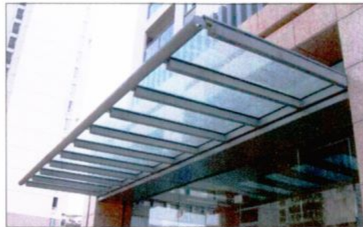
钢雨篷七(端部有排水管)
